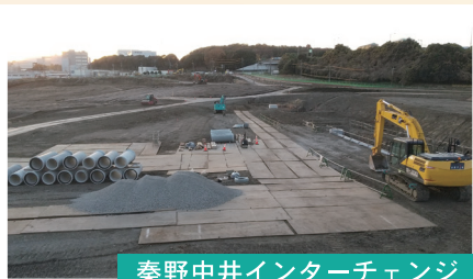
秦野中井インターチェンジ
